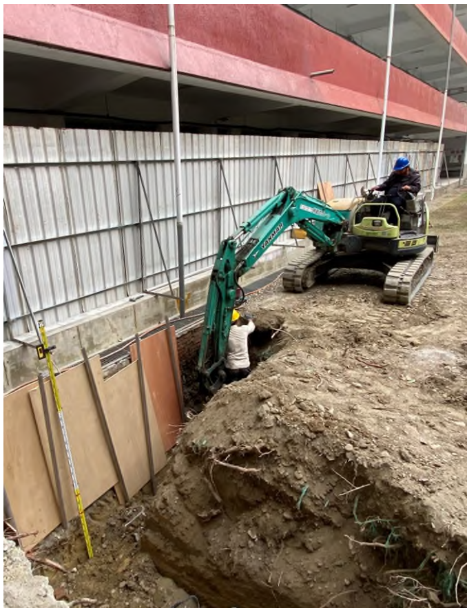
無障礙電梯基礎結構工程
