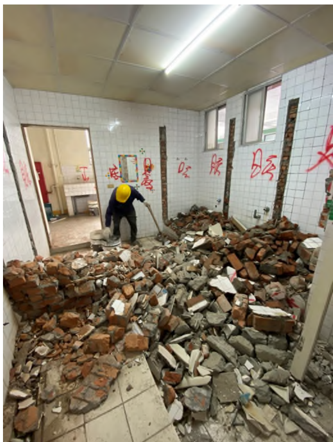
無障礙廁所打除及水電配管工程
